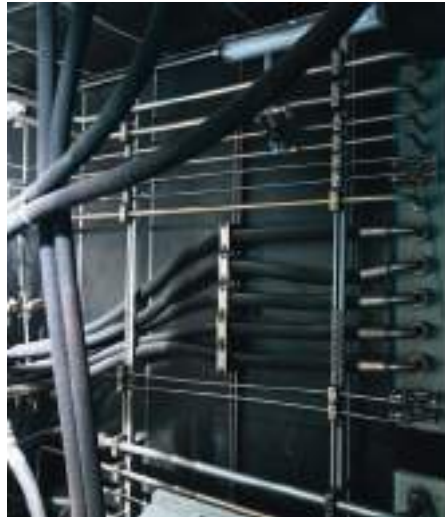
↑ Übersichtlicher, schallsisolierter Maschinenraum
