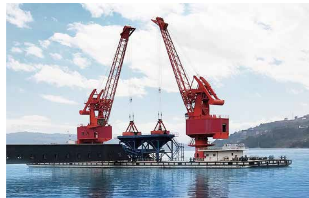
浮式门座 Floating Portal Crane
